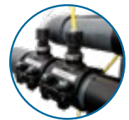
Messwasser und Impfstellen fertig gesetzt
